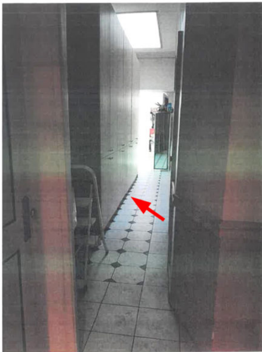
Pièce jointe n° 4 : photo des armoires murales après travaux (2019) :
